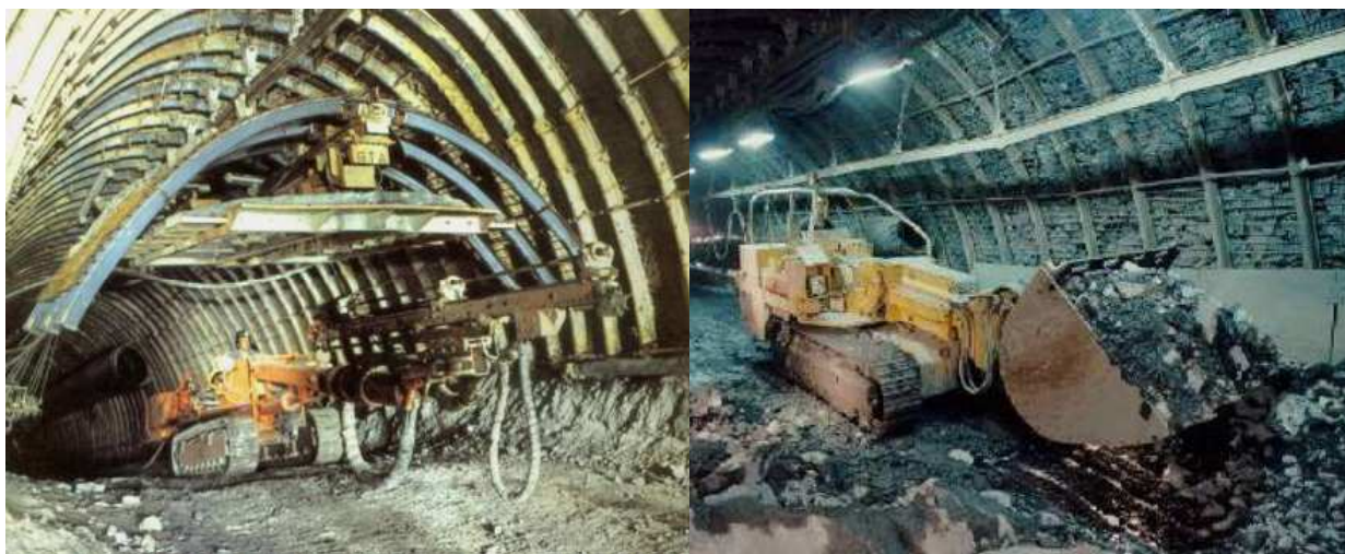
Rys.9. Widok autonomicznego kompleksu chodnikowego z wozem wierniczym jednoramionowym, ładowarką dołową bocznie sypiącą oraz samojezdną platformą roboczą
