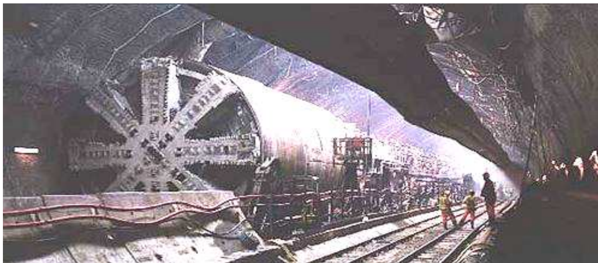
Rys.7. Widok kompleksu z kombajnem pełnoprzekrojowym
