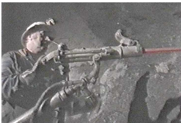
Rys.2. Widok wiercenia w przodku otworów strzałowych, wykonywanych ręcznie z podpory pneumatycznej
