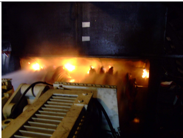
Rys.8. Gaszenie płomienia gazowego z użyciem powietrzno-wodnej kurtyny zraszającej
