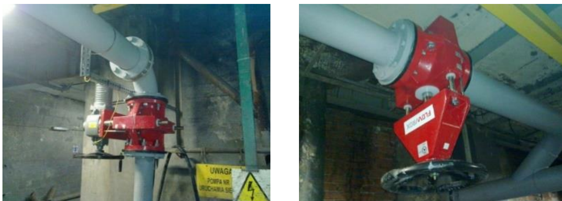
Rys. 7, 8. Zawory zaciskowe FLOWROX z napędem elektrycznym AUMA oraz kółkiem ręcznym (źródło: materiały Flowrox)
