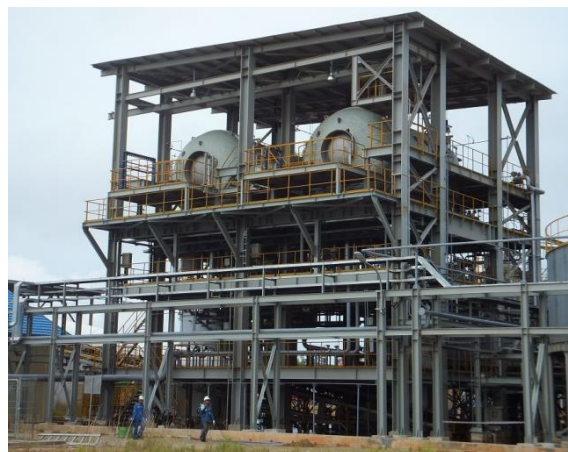
Rys. 3. Budynek filtrów z dwoma filtrami tarczowymi HiBar o pow. 70 m 2 każdy (źródło: opracowanie własne)
