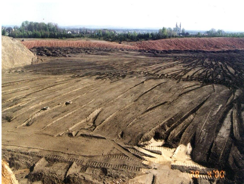
Rys. 9. Rekultywacja techniczna Odkrywki Krążek – pow. 7,5 ha
