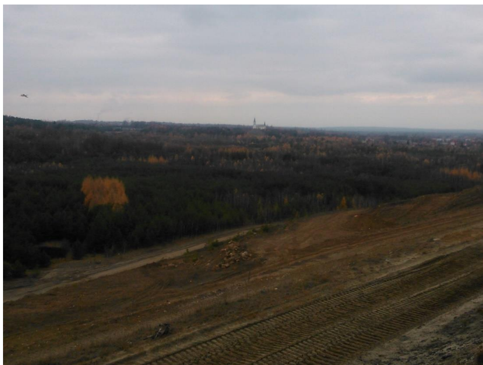
Rys. 8. Teren byłej Odkrywki Ujków po zakończeniu prac rekultywacyjnych
