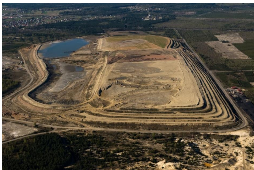
Rys. 3. Stawy osadowe odpadów flotacyjnych
