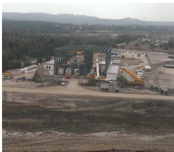
Rys. 11. Zakład Przerobu Odpadów Flotacyjnych w budowie
