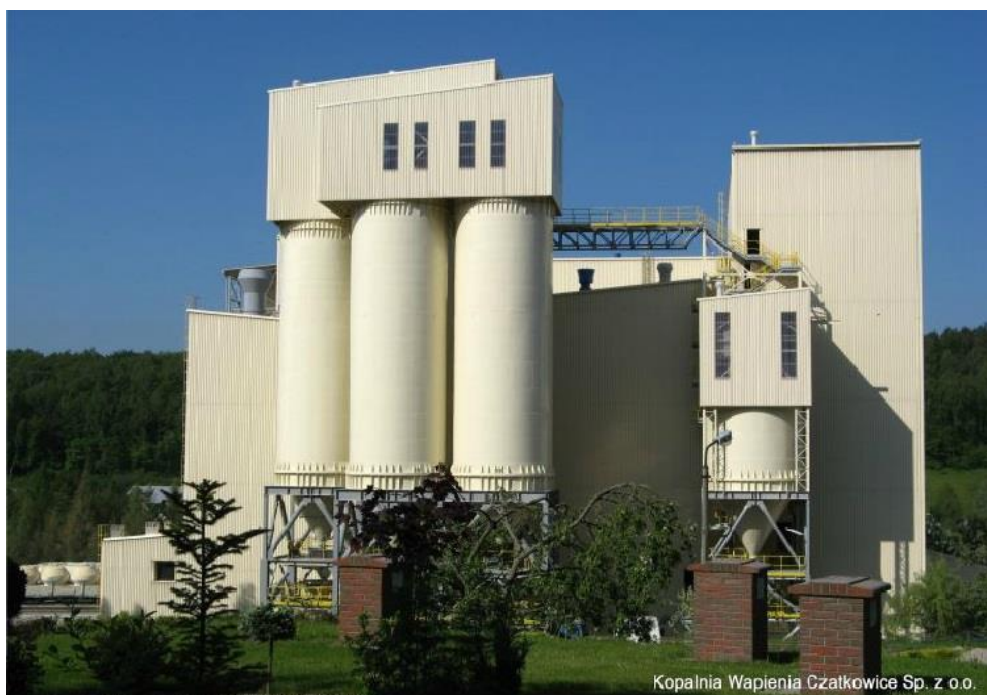
Rys. 4. Poprawa parametrów akustycznych w części przeróbczej kopalni Czatkowice [8]
