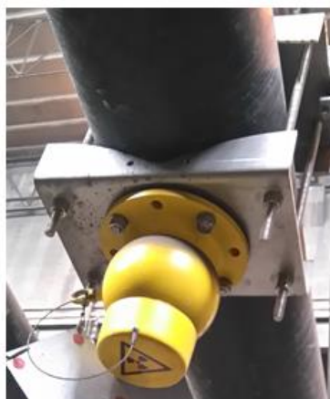
Rys. 3. Przepływomierz elektromagnetyczny i gęstościomierz izotopowy [17]
