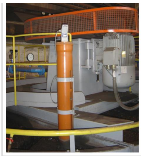
Rys. 4. Czujnik ultradźwiękowy odległości z rurą pływaka
