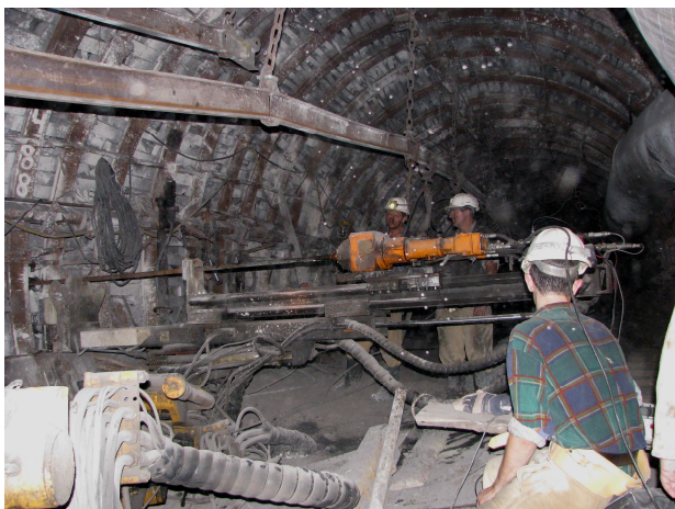
Rys.6. Próby wiercenia w ociosie chodnika wozem wiertniczym MWW-1
