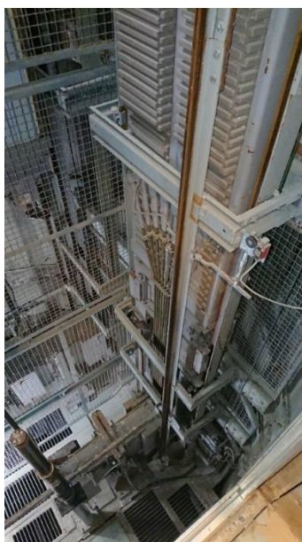
Rys. 4. Widok pomostu bezpieczeństwa i zabudowanych w nim urządzeń
