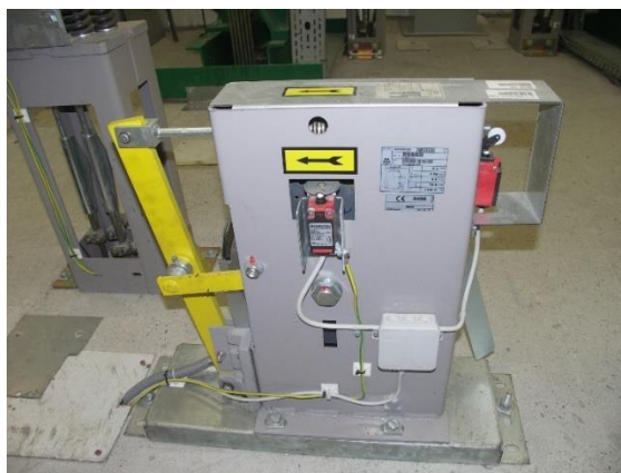
Rys. 10. Ogranicznik prędkości
