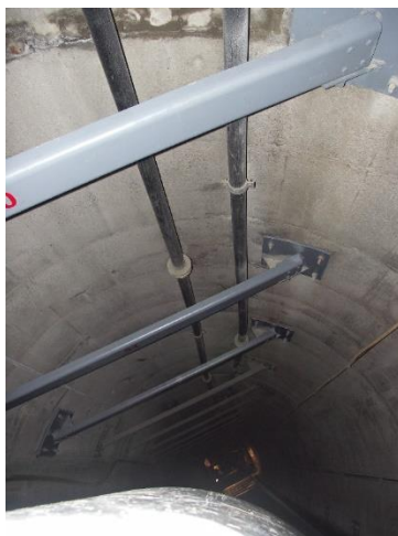
Rys. 2. Zbrojenie szybu przed zabudową elementów prowadzenia dźwigów [9]
