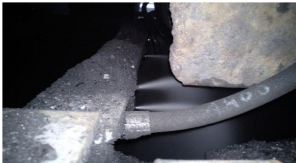
Rys. 8. System wytwarzający strumienie powietrzno-wodne, podczas prób [7]
