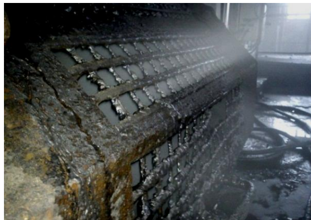
Rys. 9. Efekt osadzania się zwilżonego pyłu na kracie rewizyjnej [7]
