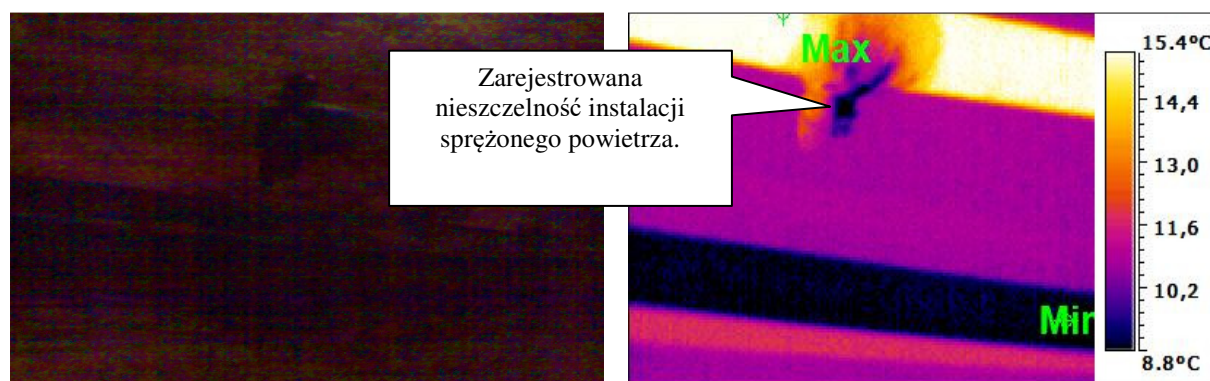
Rys. 10. Zdjęcie wizyjne wraz z termogramem fragmentu monitorowanej instalacji rurociągowej ze sprężonym powietrzem [6]
