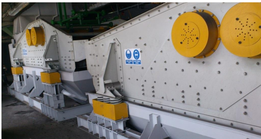
Rys.11. Odbiór węgla na przesiewacze odwadniający i sortujący po wzbogacalniku DISA
