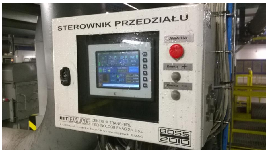
Rys.4. Sterownik przedziałowy systemu BOSS2010 [źródło: opracowanie własne]
