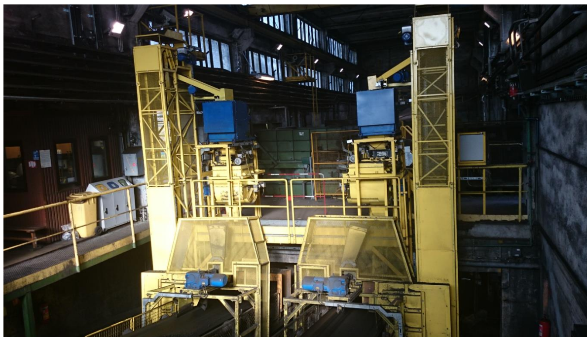
Rys.2. System automatycznego poboru próbek na taśmociągach T7A i T7B w EDF Rybnik [2]
