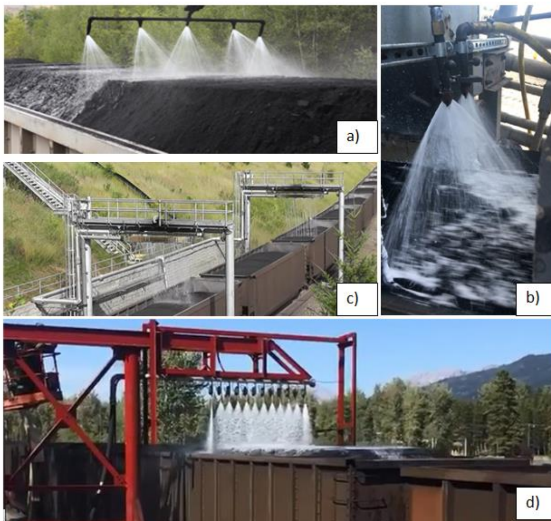
Rys. 4. Przykład instalacji natrysku powłoki zabezpieczającej: a) Firma Neo Solutions, Inc. z siedzibą w Beaver, Pennsylvania (USA) [17], b) Firma MinTech Headquarter's Ellsworth Industrial Drive NW, Atlanta, (USA) [18], c) Firma Rail Shop Services Inc., Edmonton, Kanada Zabudowa na CP Coal Respray: Tappen, Kolumbia Brytyjska [19], d) Firma Sparwood & Teck Resources, Kanada [20]
