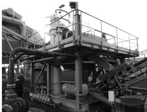
Rys.4. Widok osadzarki K-100 w Zakładzie Produkcji Betonów w Zdzeszowicach
