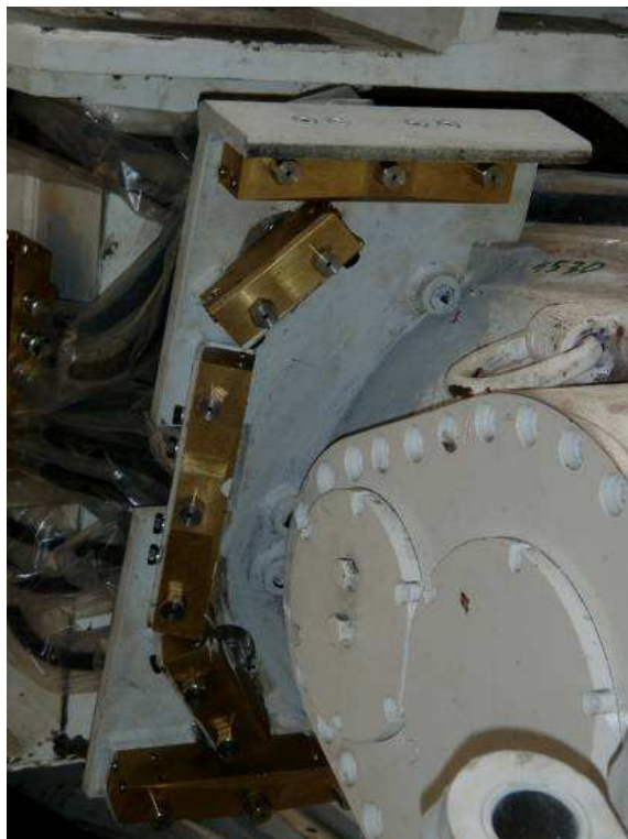
Rys.3. Bateria zraszająca zabudowana w układzie „C” [6]
