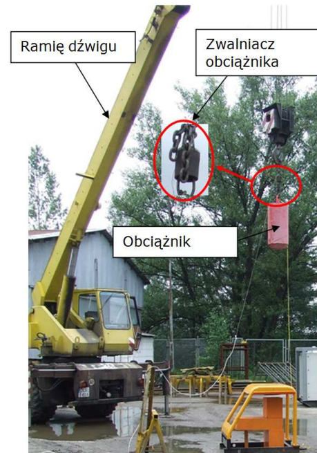
Rys.6. Stanowisko do badań niszczących konstrukcji ochronnych operatora [1]
