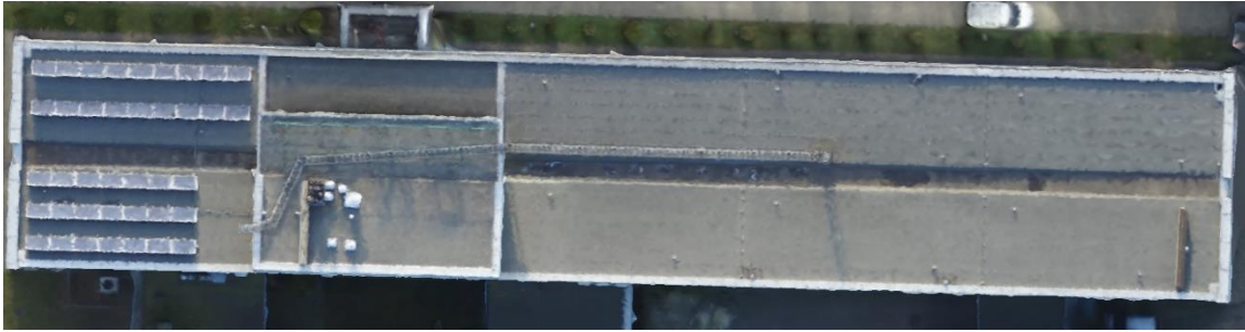
Rys.2. Widok dachu budynku A
