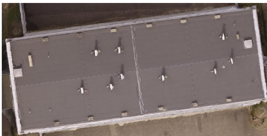
Rys.4. Widok powierzchni dachu budynku auli
