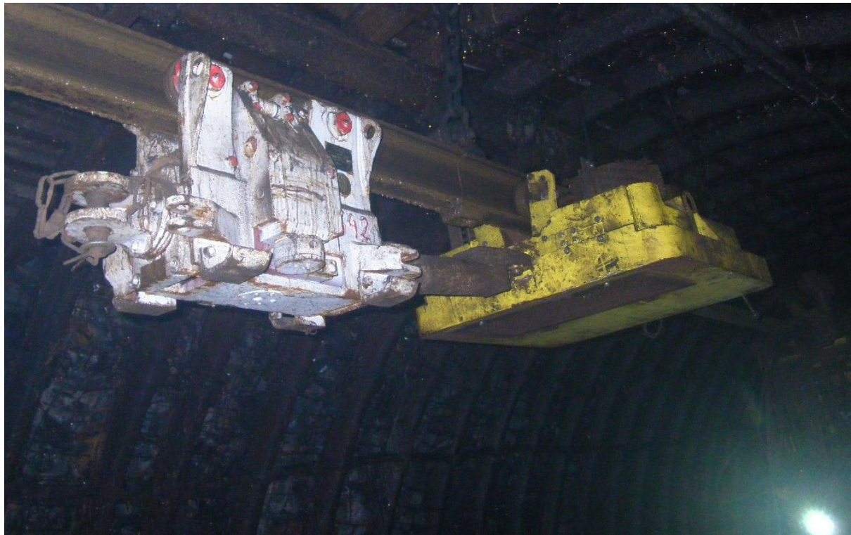
Rys. 10. Zabudowa prototypu MUC-1 podczas dołowych prób eksploatacyjnych [5]
