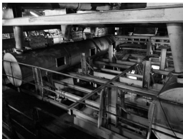
Rys. 2. Osadzarka mialowa OM30 KWK Sośnica w trakcie montażu
