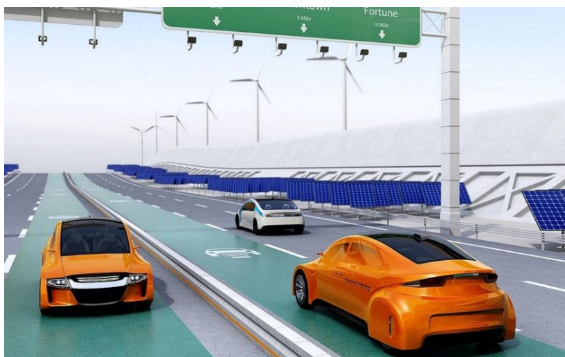
Rys. 4. Widok drogi z pasami zielonymi do ładowania indukcyjnego [8]
