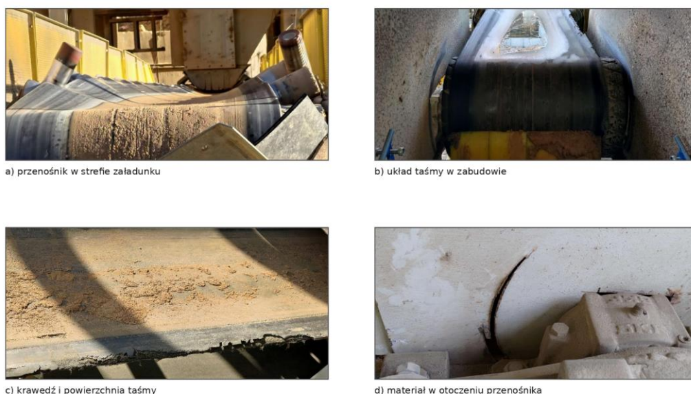
Rys. 1. Przykłady obszarów obserwacji w diagnostyce przenośnika taśmowego
