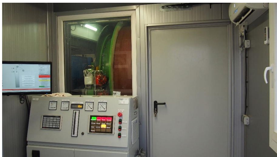
Rys. 4. Klimatyzowane stanowisko sterownicze
