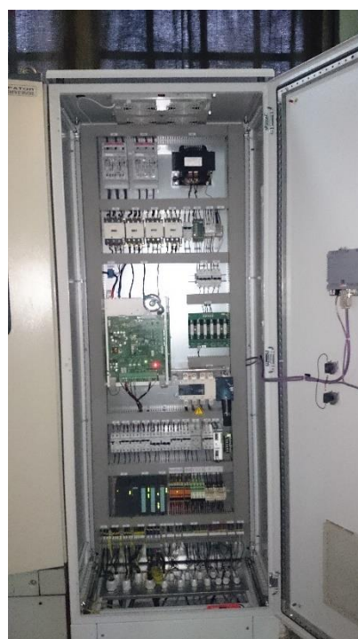
Rys. 3. Szafa SS wzбудnicy tyrystorowej WM i przełącznicy POW
