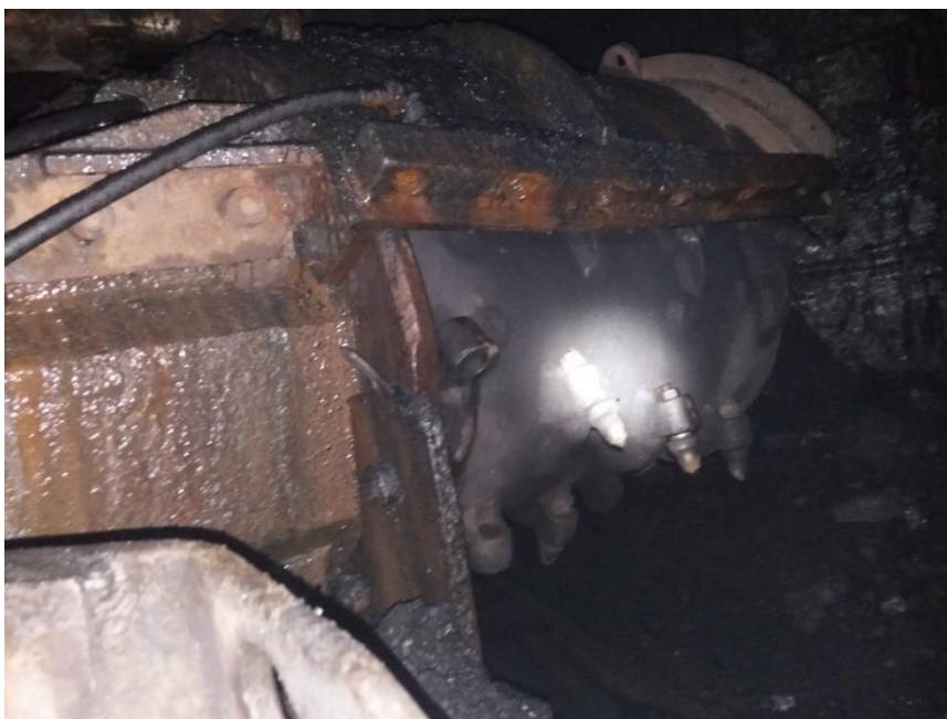
Rys. 8. Ścianowa kruszarka KS4 w wyrobisku ścianowym [źródło: opracowanie własne]
