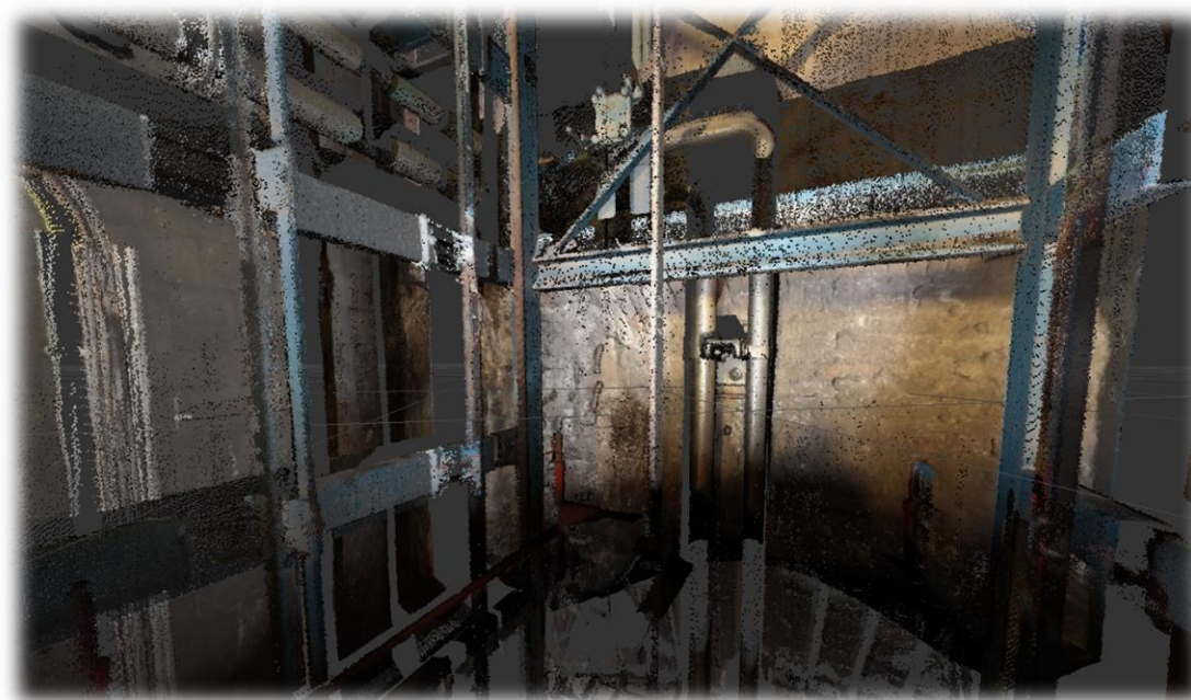
Rys. 2. Widok krzesła szybowego na poziomie 170
