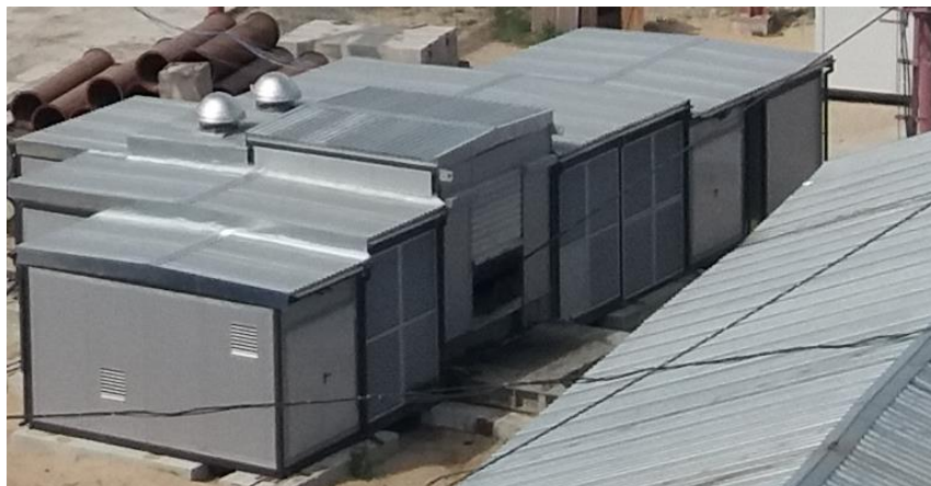
Rys. 2. Zabudowa kontenerowa maszyny wyciągowej MPPP-21 [źródło: opracowanie własne]
