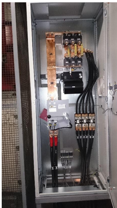
Rys. 2. Szafa SPR prostownika diodowego i odłącznika P
