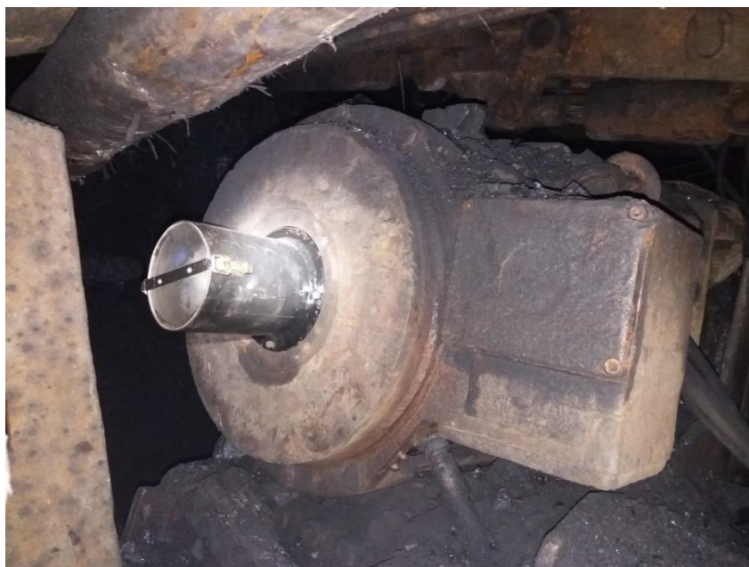
Rys. 9. Układ pomiarowo-rejestrujący zabudowany w kruszarce KS4 w wyrobisku ścianowym (źródło: opracowanie własne)
