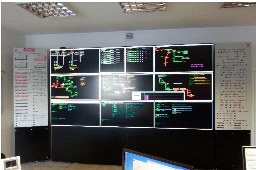
Fot. 23. Na zdjęciu zespół tablic synoptycznych w pomieszczeniu dyspozytorni (źródło: materiały własne)
