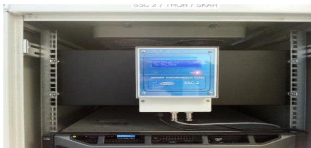
Fot.27. Moduł serwera czasu SSC-2 (źródło: materiały własne)
