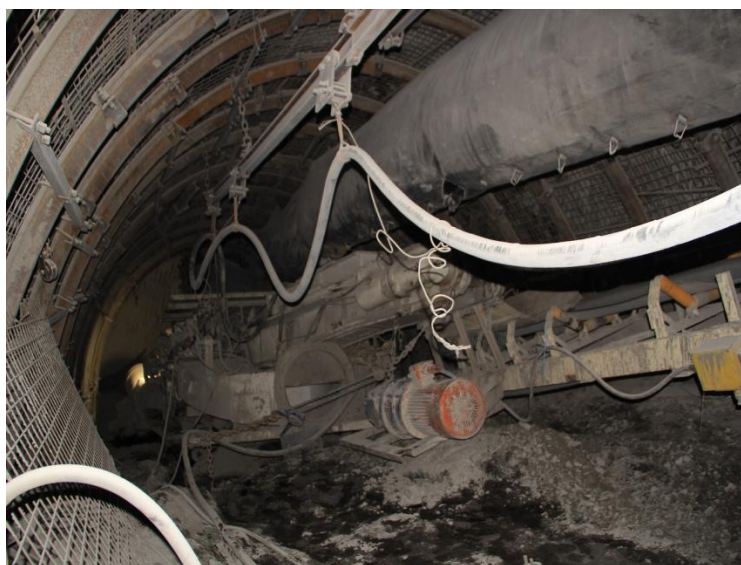
Rys.4. Przodek chodnika drążonego kombajnem chodnikowym wraz z wyposażeniem [zdjęcie autor]
