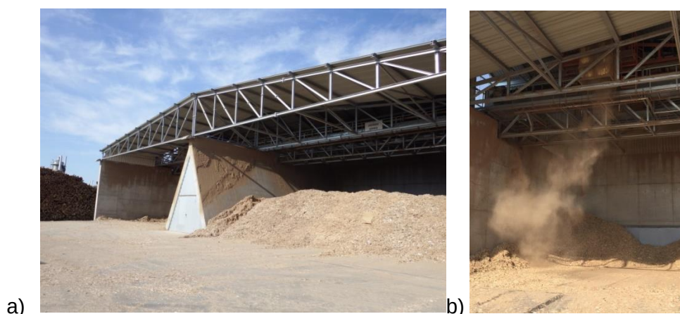
Rys. 7. Zakład przetwórstwa drewna: a) komory składowania wkładu drewnianego b) stalowy wysyp przenośnika taśmowego [10]
