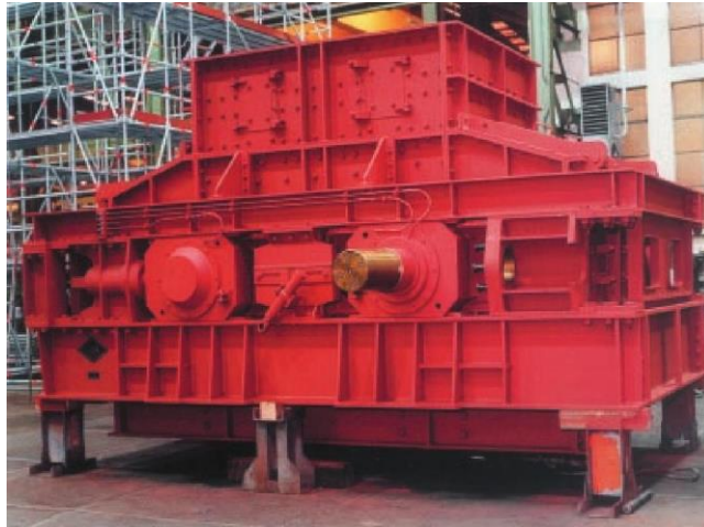
Rys. 3.3. Kruszarka walcowa do wstępnego kruszenia kamienia wapiennego firmy ThyssenKrupp [12] podczas montażu
