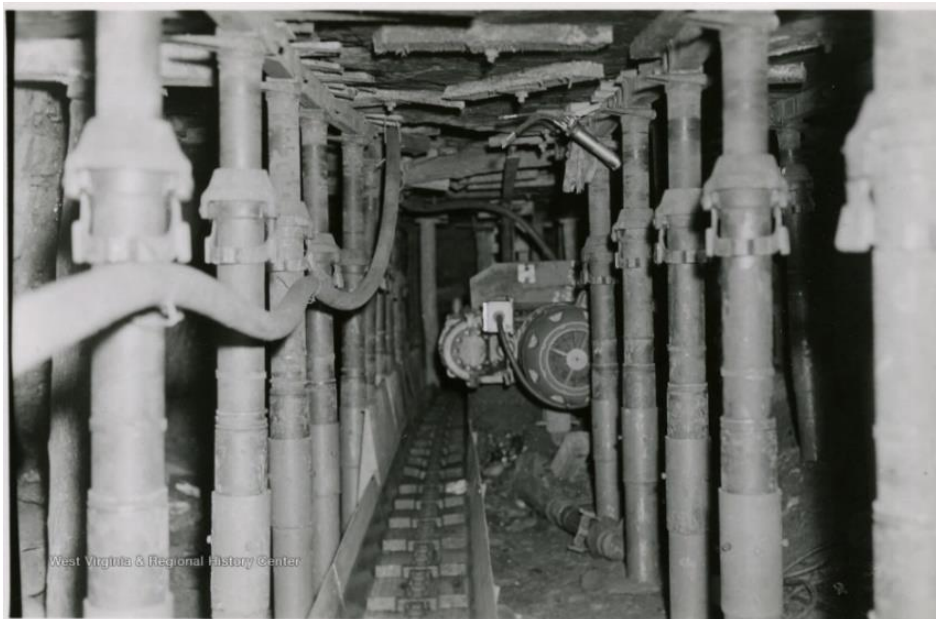
Fot. 2.1. Chodnik podścianowy z przenośnikiem zgrzeblowym i dodatkowym wzmocnieniem stojakami stalowymi w rejonie okna ściany [4]
